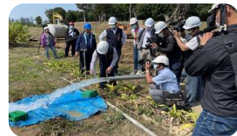
▲ 本校陪同進行既設抗旱井現場抽查作業情形
